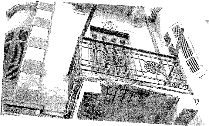
صورة رقم (٢٠) استخدام الكوابيل في حمل البروزات.
